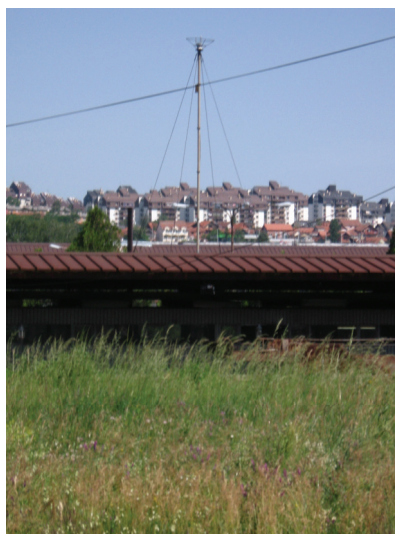
Слика бр. 40. Замена громобранске инсталације
