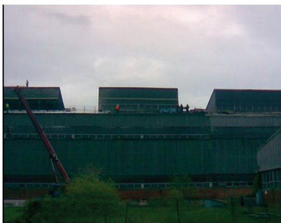
Слика бр. 42. Активности на реконструкцији објекта
